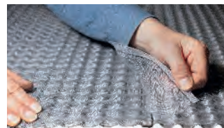
Verlegung der DURABASE DD 80++ Doppel-Drainagematte mit Überlappung
